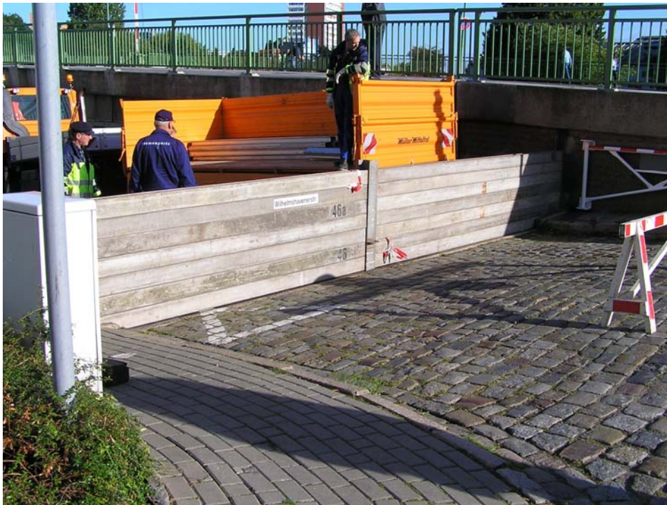
Dambalkenverschluss in der Wilhelmshavener Straße
