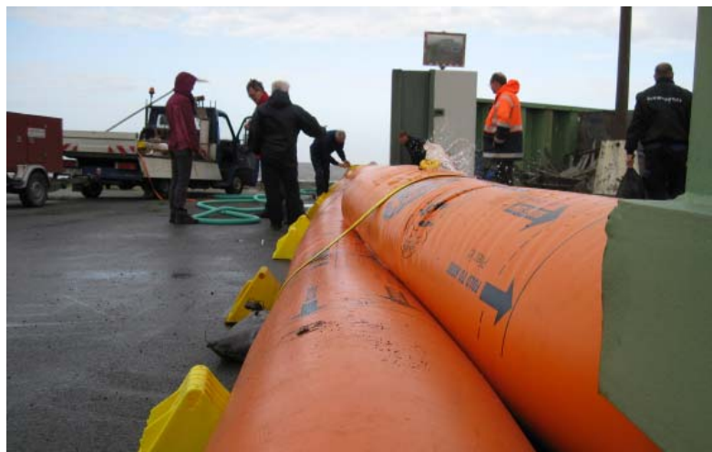
Übung von bremenports-Mitarbeitern mit Hochwasserschutzschläuchen
