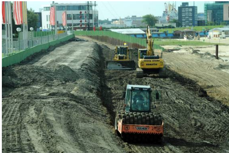
Bauarbeiten am Weserdeich im Sommer 2011
