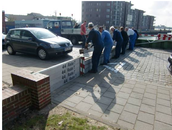
bremenports-Mitarbeiter bei der Einlegung von Dammbalken für die technische Verschlusschau
