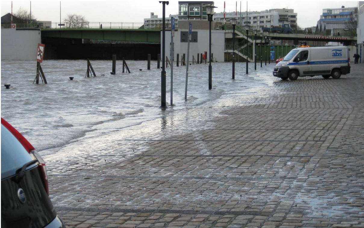
Sturmflut im Bereich der Geeste am 09.12.2011
