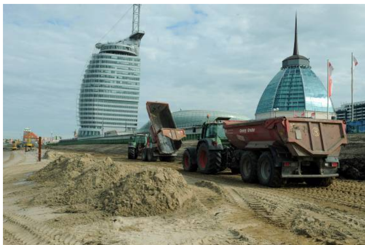
Bauarbeiten am Weserdeich vor dem Sail-City Gebäude
