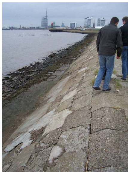
Beseitigte Abbruchstellen am Deckwerk Seedeich
